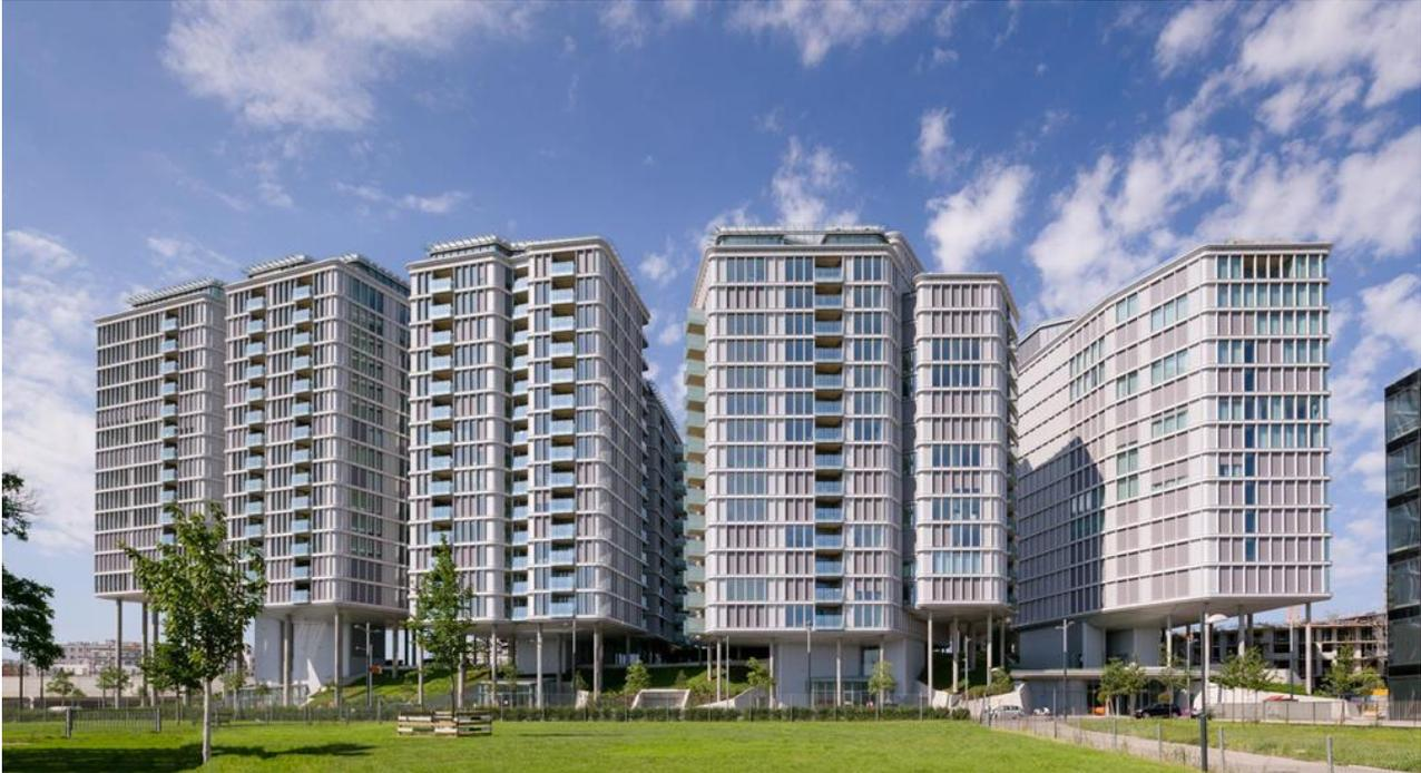
**Abbildung 15: Moderne Wohnhäuser auf erhöhten Punktfundamenten mit weitgehend freier EG-Zone. Arsenalstraße 12-16, Wien 1100. Quelle: <https://www.alukoenigstahl.at/de/unternehmen/referenzen/park-apartments-am-belvedere>**
