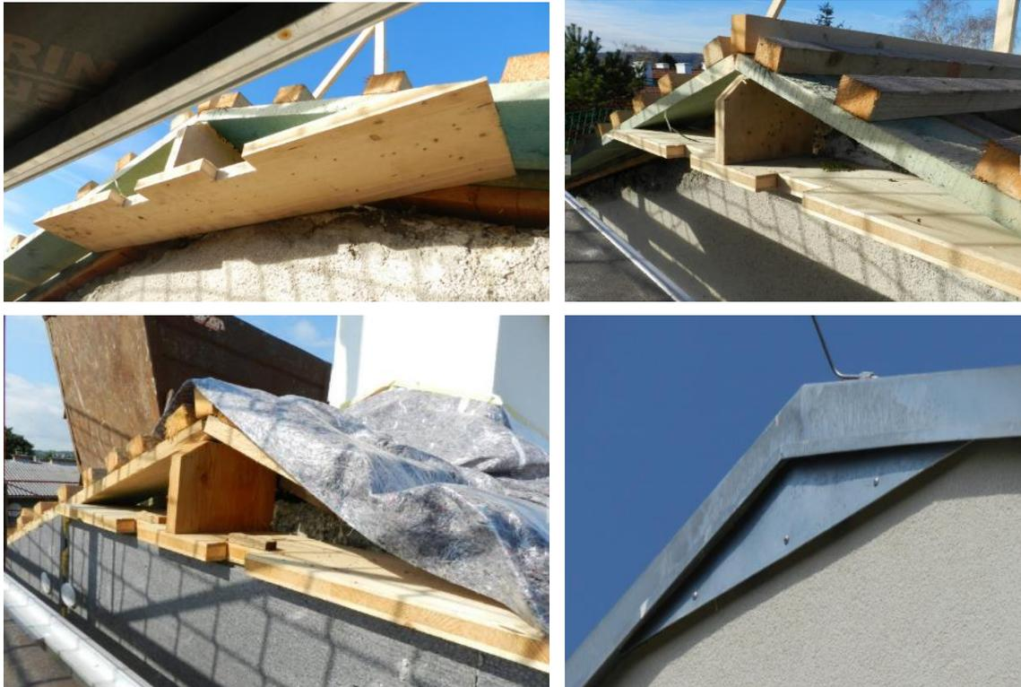
Abbildung: Nischenbildung: a) Montage Doppelnische aus Holz, b) Dämmung bis unter Holzkonstruktion, c) Dachabdichtung, d) Verblechung
