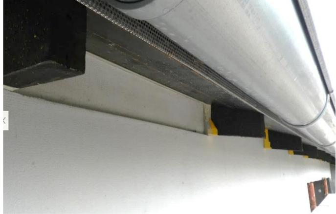
Rücksprünge (2 cm) in Wärmedämmung zwischen Dachsparren als Stütze für Naturnester
