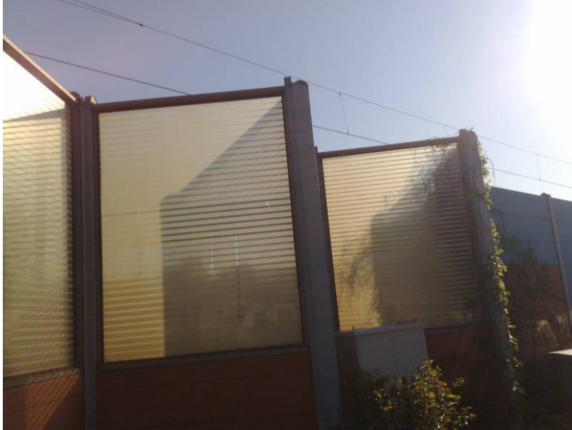
Abb. 7 verätzte Lärmschutzwände der ÖBB
