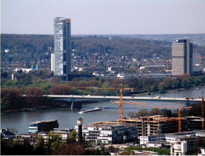
Abb. 1: Der Post-Tower mit seiner Umgebung von Osten gesehen. Rechts im Bild der „Lange Eugen“.
