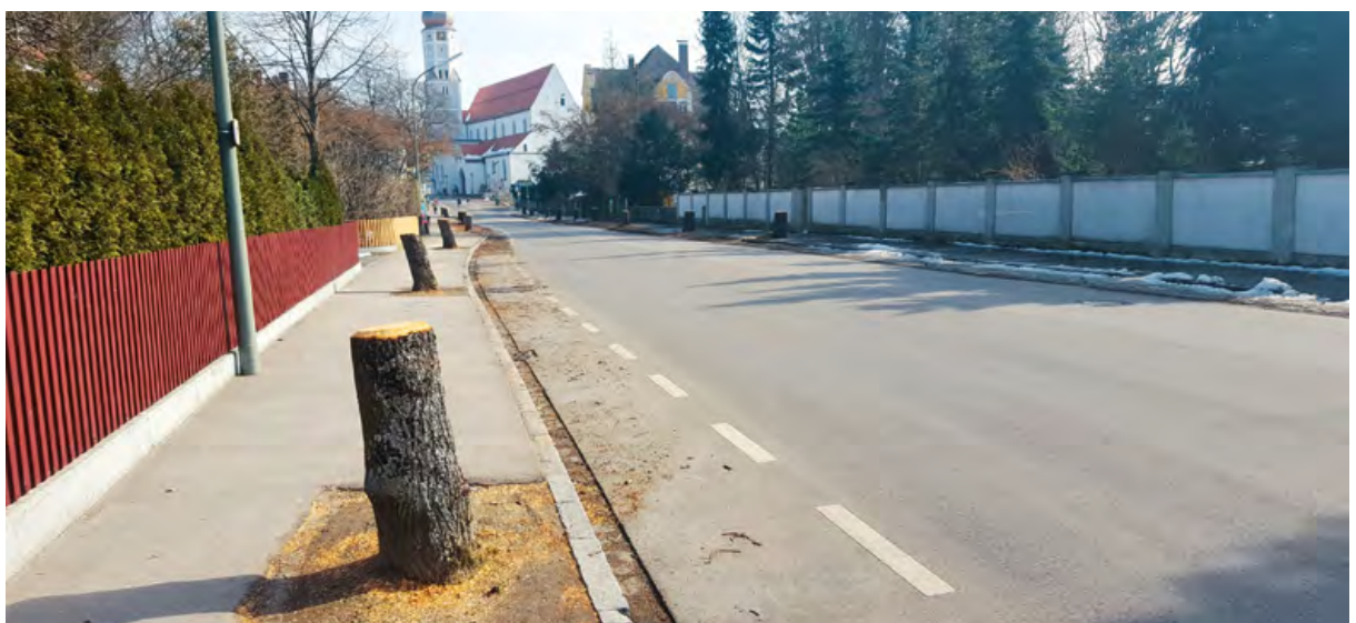
Baumfällaktion im Rahmen einer Straßensanierung. Bei derartigen Maßnahmen sollten Konzepte bevorzugt werden, die den Erhalt des Grüns sicherstellen.
