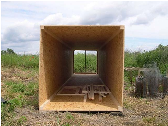
Abbildung.5: Rohkörper des Versuchstunnels horizontal und nach Norden ausgerichtet. Die Gesamtlänge beträgt 7.50 m.
