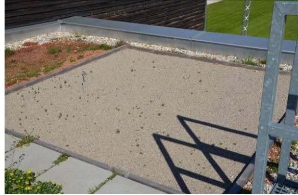
Abbildung 14: Versuchsfläche Wiesendrusch im Freiland am Dach, April 2012
